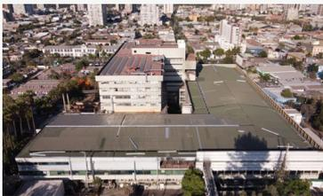
Desmantelamiento de piso mecánico e instalación de cubierta provisoria
