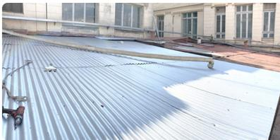
En la Unidad de Gases Clínicos, se realizaron trabajos para cambiar la techumbre que alcanza una superficie de 140 m<sup>2</sup>. La anterior se encontraba desgastada por el tiempo, generando filtraciones de agua lluvia.
